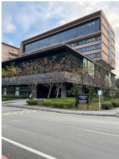
イノベーション・インキュベーション棟
